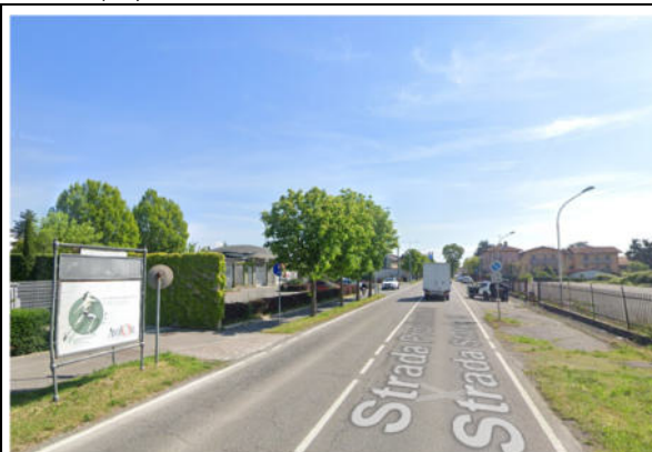
Foto 10: SP 11 in direzione sud (presso l'ingresso dell'ex stabilimento Invernizzi)
